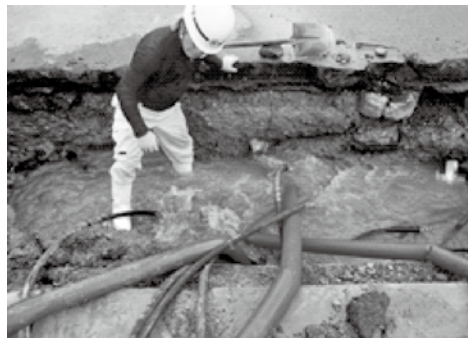
補修工事の様子
