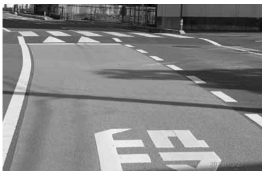
上岩出小学校前のスムーズ横断歩道
