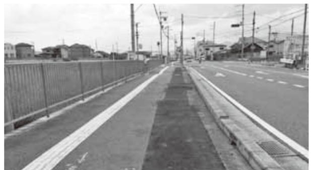
に北側の歩道の下に計画しており、歩道の路側擁壁溝施工後でなければ水道管の埋設が出来ないため、水道工事が着手まで仮舗装としていた。
