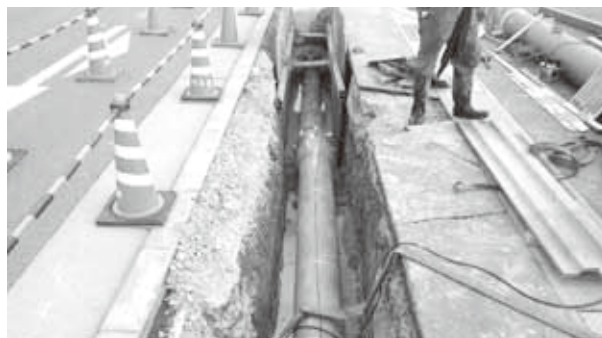
水道管布設替えの様子
