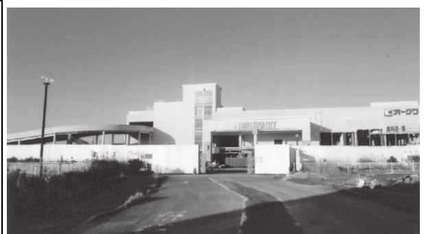
大規模商業施設の解体
