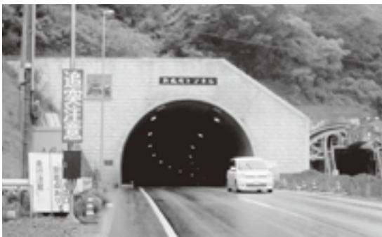
新風吹トンネル
