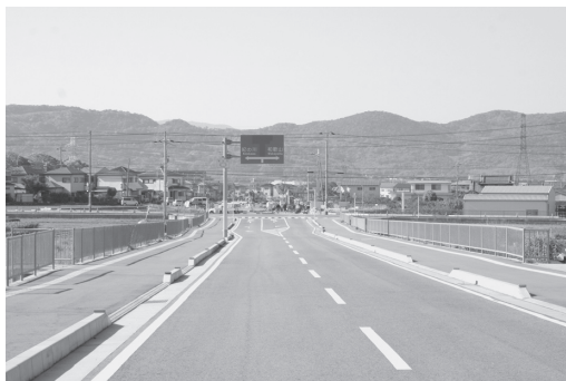
市道安上中島線と農免道路交差点付近
