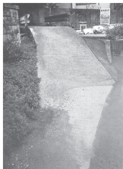
中迫団地北側の藤崎井用水路の橋付近
