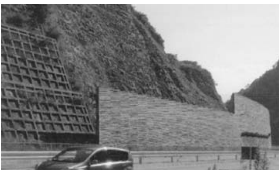
風吹トンネル手前
