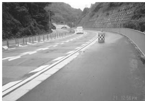
新風吹トンネル出口付近
