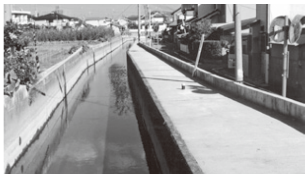
藤崎用水のかさ上げ状況
