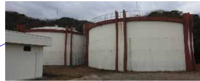
第4配水池(紀泉台低区配水池)
