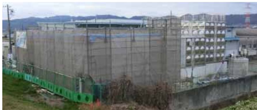
建設中の新中島浄水場
