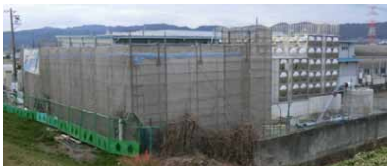
写真 3.1.1 建設中の第 3 浄水場
