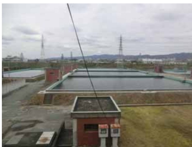
写真 3.2.1 第1浄水場緩速ろ過池
