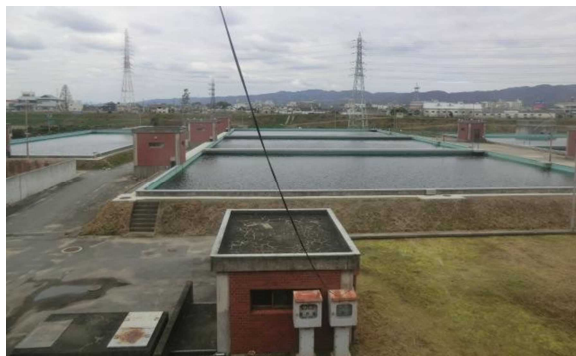
写真 3.2.1 第1浄水場緩速ろ過池
