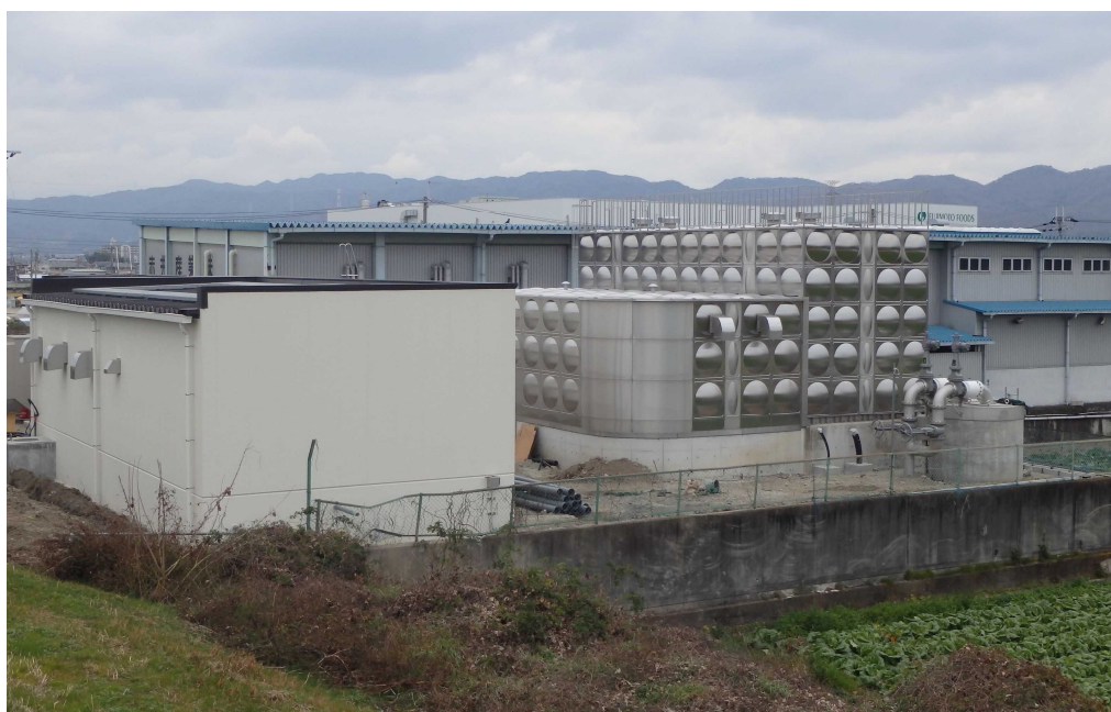
写真 3.1.1 建設中の第 3 浄水場
