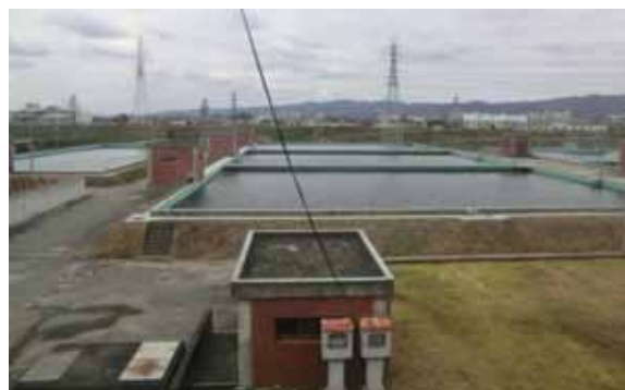
写真 3.2.1 第1浄水場緩速ろ過池
