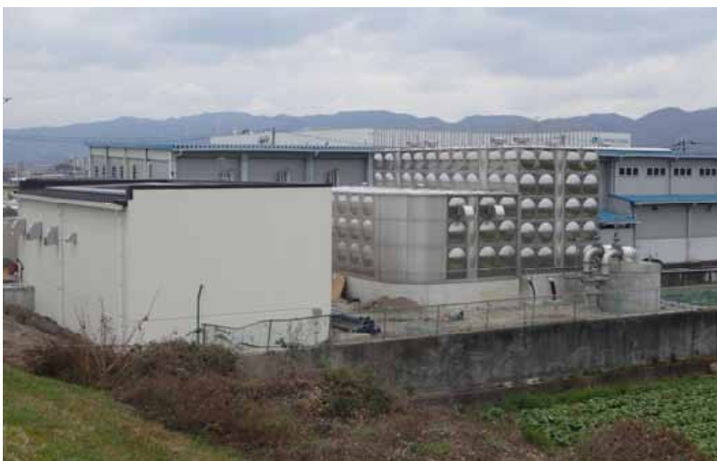
写真 3.1.1 建設中の第 3 浄水場
