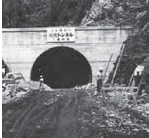
風吹トンネル工事(昭和41年)
