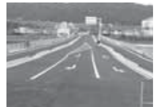
着々と進む都市計画道路安上中島線の道路建設 (湯窪地内)
