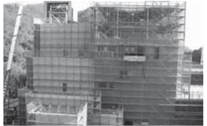
平成20年度本格稼働に向け工事が進む新クリーンセンター
