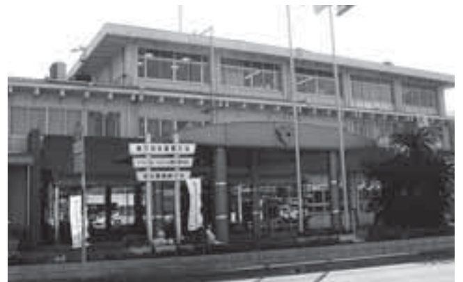
耐震対策のため耐震二次診断を実施する市役所庁舎
