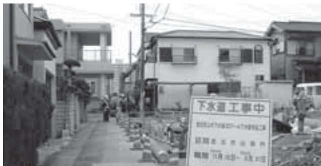
平成20年12月に供用開始する下水道事業(下水管布設工事)
