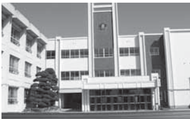
西校舎大規模改造工事を行う上岩出小学校
