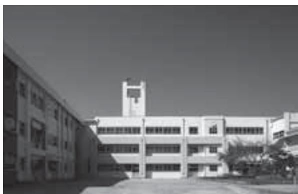
根来小学校管理棟・南校舎
