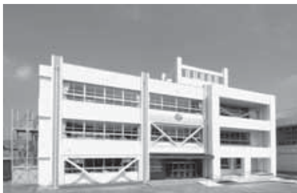
岩出小学校管理棟
