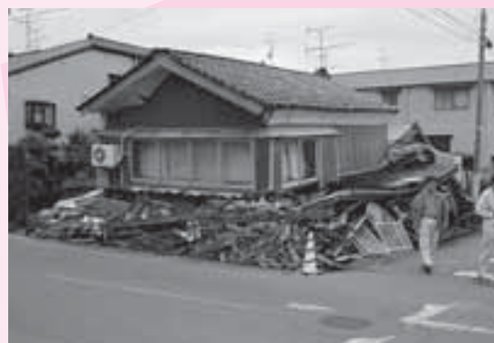
■ 一階部分が倒壊した住宅
