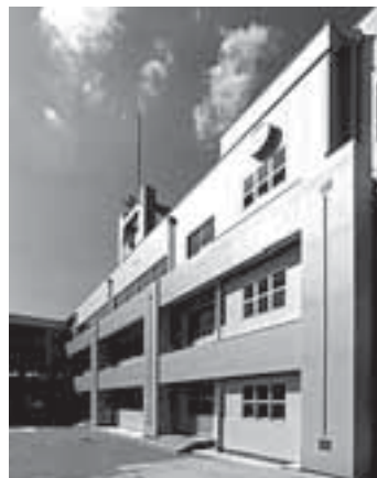
耐震補強工事が完成した根来小学校
