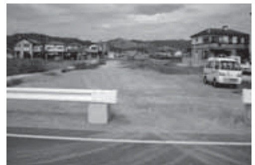
平成23年度完成に向け事業を進める 市道湯窪中島線新設事業
