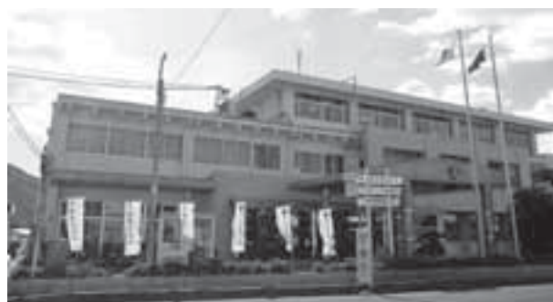
耐震補強工事が完了した市役所庁舎
