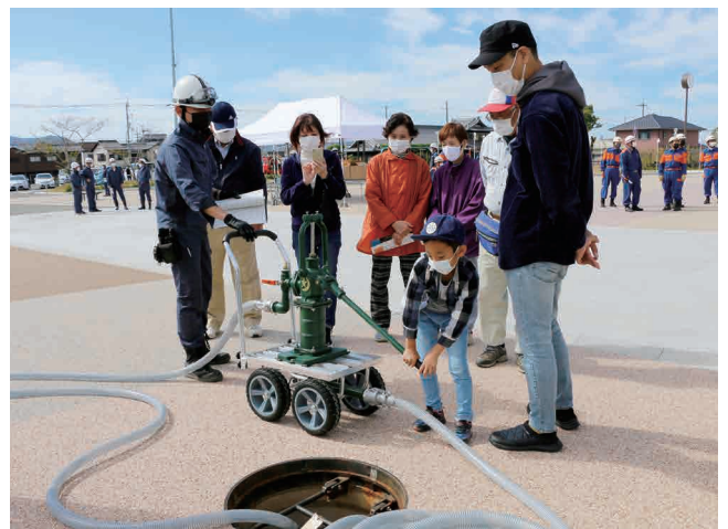
▲防火水槽の水を汲み上げマンホールトイレに流します
