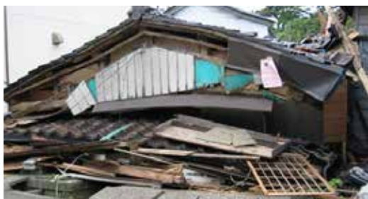
地震により倒壊した家屋
