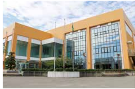
⑬ 岩出市立市民総合体育館
