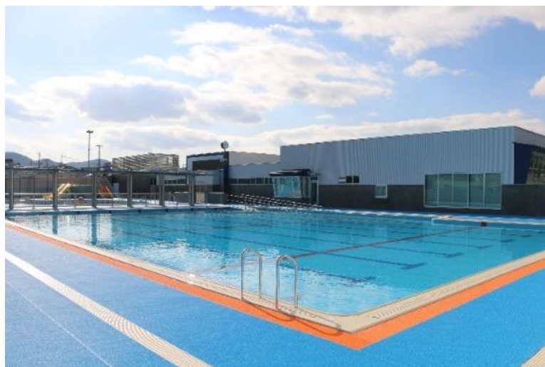
岩出市民プール
