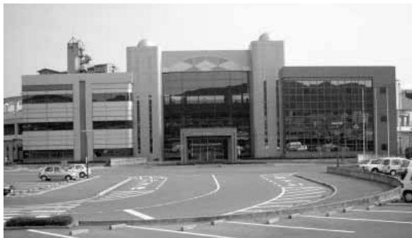
災害時に福祉避難所となる総合保健福祉センター
